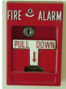
รูปที่ 1 อุปกรณ์ส่งสัญญาณเตือนไฟไหม้ของอาคารมหามกุฏ
