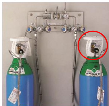
รูปที่ 2.2 ตัวอย่างถังแก๊สที่มี guard ป้องกันหัวถัง ขณะใช้งาน
