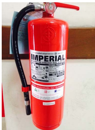
รูปที่ 1 เครื่องดับเพลิงประเภทผงเคมีแห้งที่มีติดตั้งในภาควิชาเคมี
