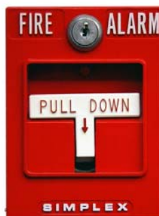
รูปที่ 5 อุปกรณ์ส่งสัญญาณเตือนไฟไหม้ของอาคารมหามกุฏ
