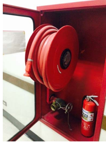
รูปที่ 2 ตู้ดับเพลิงที่มีสายส่งน้ำแบบขมวดม้วน
